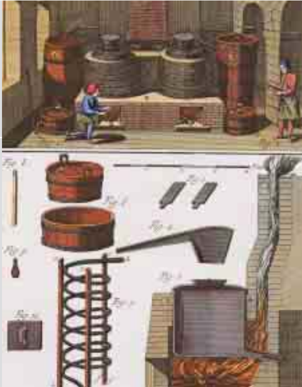
Erst durch die im Mittelalter aufkommende Technik der Destillation ließ sich aus vergorenem Alkohol Hochprozentiges gewinnen. Der Kupferstich aus der „Encyclopedie des Sciences“ von Diderot und d’Alembert (1751-1781) zeigt den Prozess.
